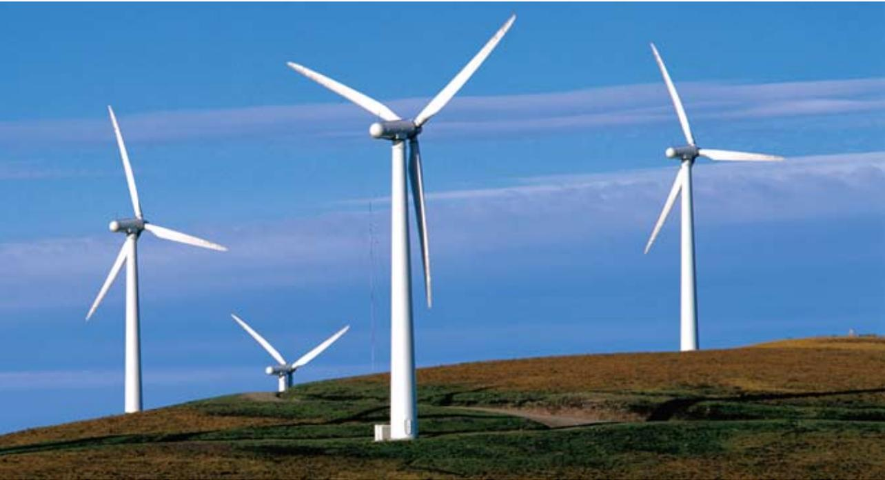
飞机可以不飞，但风电机组却要暴露在恶劣条件下，安装地点都是风大的地方，来台风了，可能达到70米每秒，风力设备要抵抗最大风速，强热带风暴，即使要有雷电来了，完全要靠设备自己抵抗，因为风机在野外运行，一般要做到无人值守，不然风力发电的成本又会提高。而且现在风机都是变速运行的，风小的时候速度低，风大的时候运转速度高，但是电网需要电压平稳。这种情况下，电网对风力发电完全按照常规的方式来考核，也有一定要求。
